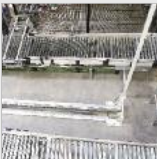
Ein herkömmliches RBG mit langen Puffer-Zonen – toter Raum.
